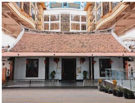
Gambar 1 Gedung Candra Naya Sumber : Penulis (2024)
