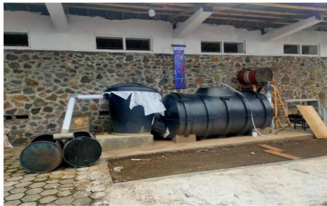
Gambar 1. Sistem Digaster Biogas di PT Biro Teknik Sinar Baru
